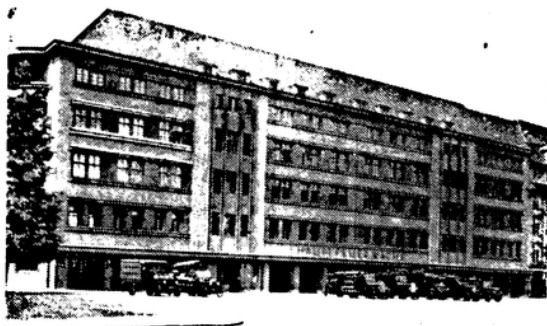
Gesamtansicht vom Fleischerplatz aus
